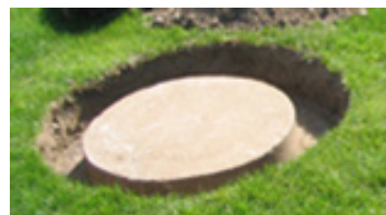
Exemple d'un couvercle bien dégagé
