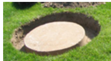
Exemple d'un couvercle bien dégagé
